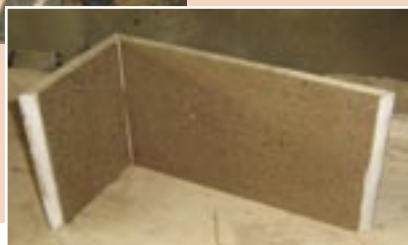
Unión en forma de L para las tablas de la cuadrícula.
