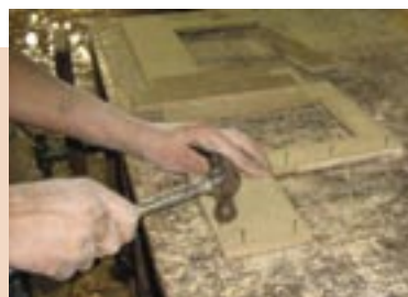
Técnica de reengruese usando puntillas sin cabeza de 1½ pulgadas.
