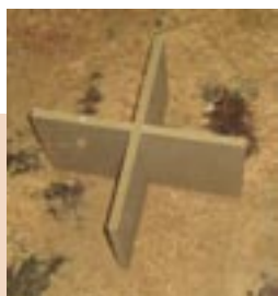
Unión en forma de cruz de las tablas interiores de la cuadrícula.
